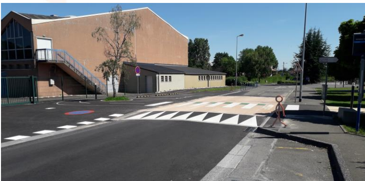
Exemples de chantier de l'agence d'Andelnans.
