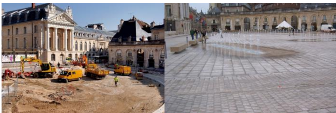
Requalification de la place de la libération à Dijon, avant/après. L'équipe de St Apollinaire s'est occupée entre autres de toute la VRD
