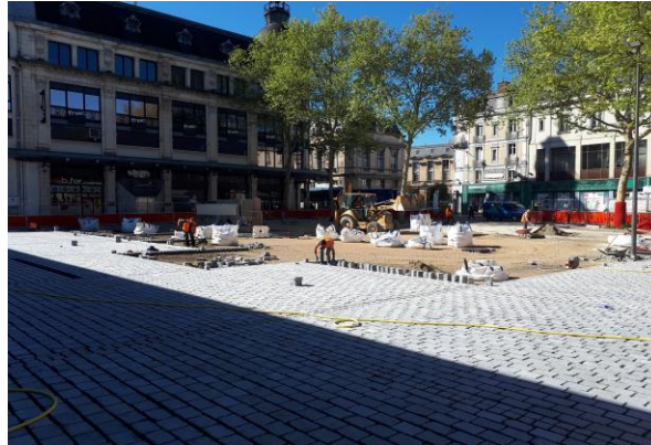
Chantier de pose de pavés
